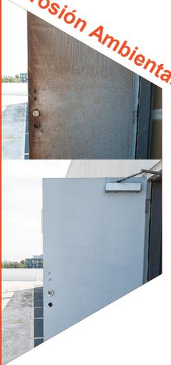
Es un sistema de recubrimiento de "superficie tolerante" que no requiere una limpieza abrasiva. Exhibe excelente adhesión a todos los tipos de metales ferrosos, así como superficies galvanizadas. Cepillo de alambre mecánico, rectificado o chorro de agua a presión es normalmente aceptable para lograr una buena adherencia.
