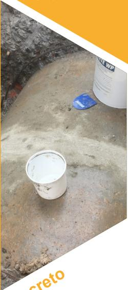
Componente cementoso, de fraguado rápido con la capacidad para detener el agua corriente a través de estructuras de mampostería. Está diseñado para ser mezclado con agua y para sanar dentro de un minuto.
